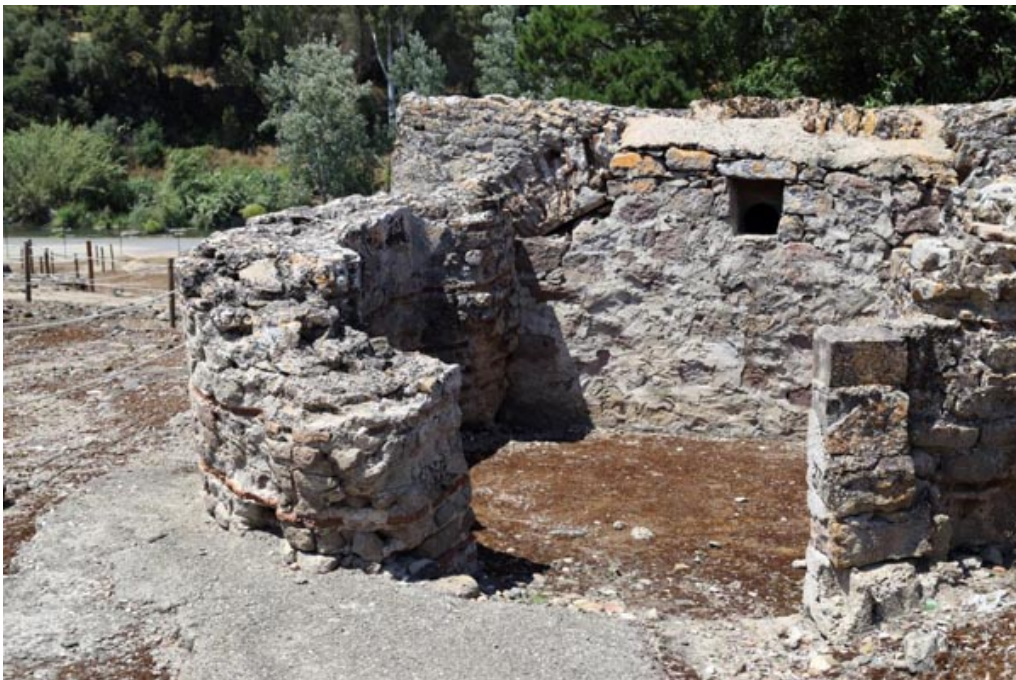
Fig. 3 - Vista del edificio desde el sur donde destaca el cuarto con ábside (foto de Unicity S.p.A.)
