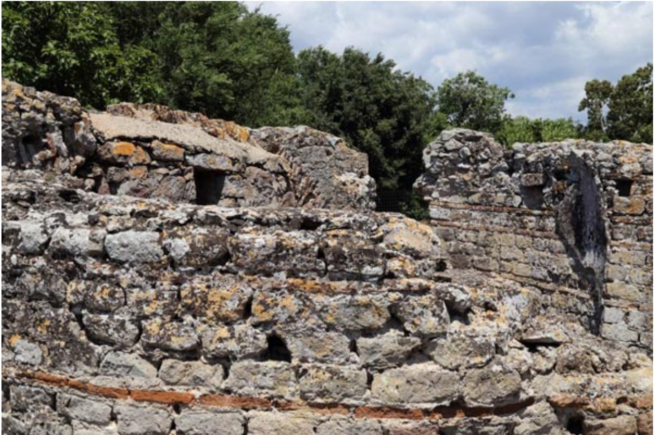
Fig. 4 - Detalle de la técnica de construcción con opus vittatum mixtum (foto de Unicity S.p.A.)
