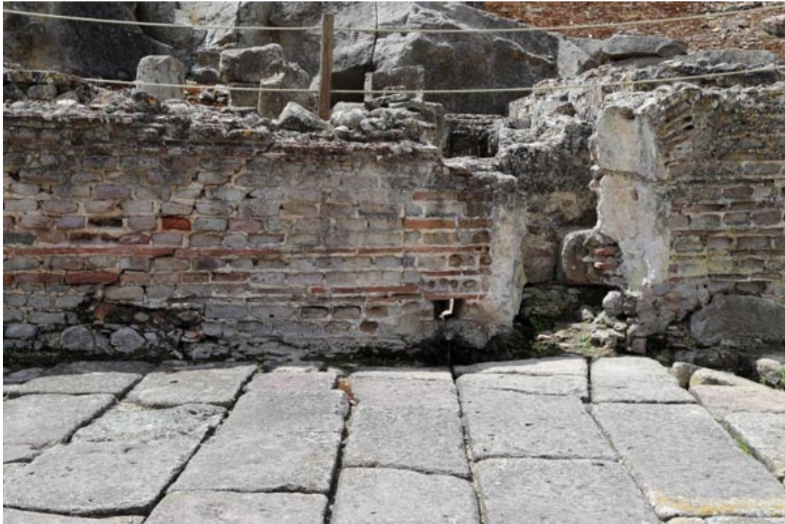
Fig. 5 - El muro que cerraba la plaza en la zona sur (foto de Unicity S.p.A.)
