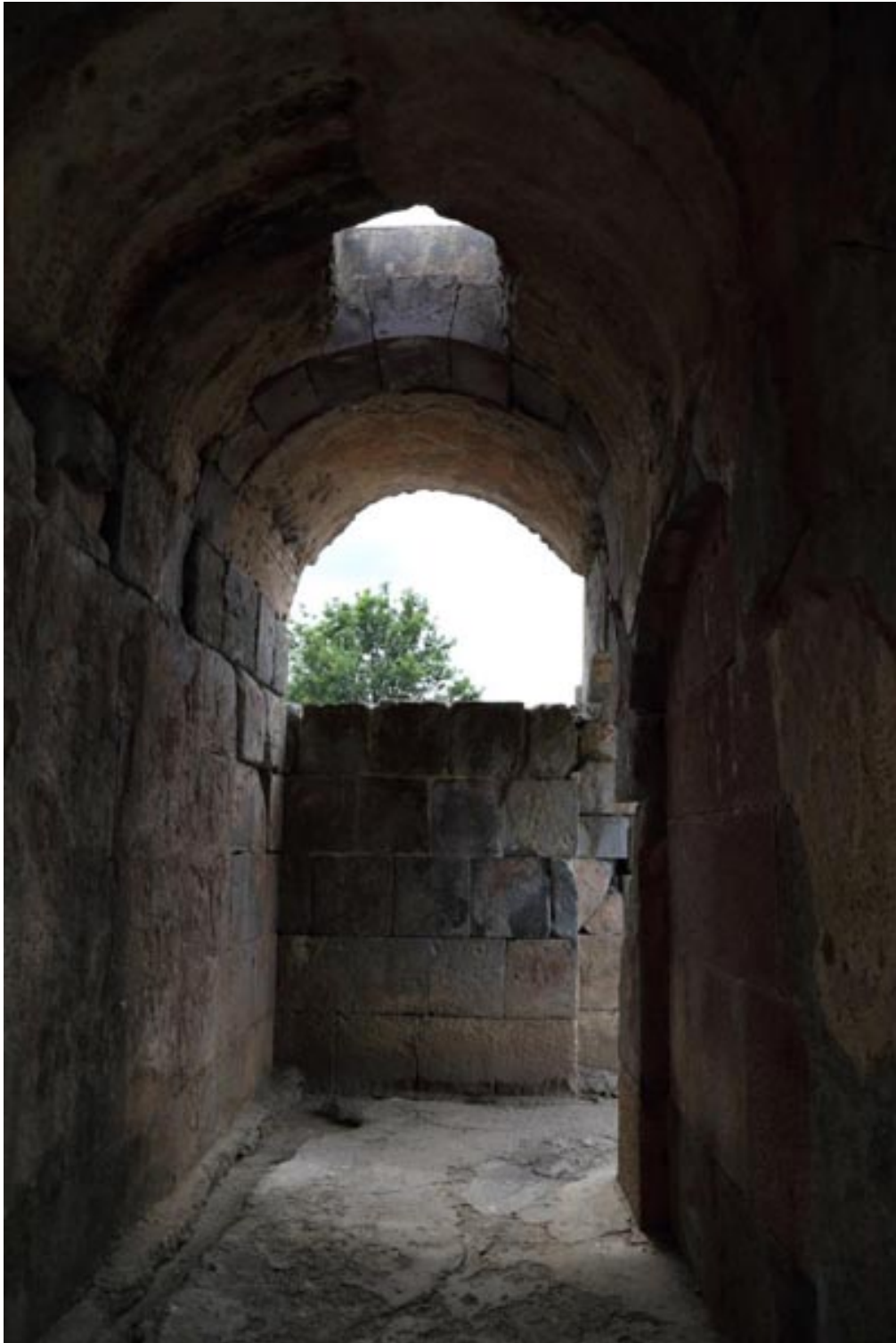
Fig. 3 - Interior del porticado del lado sur (foto de Unicity S.p.A.).
