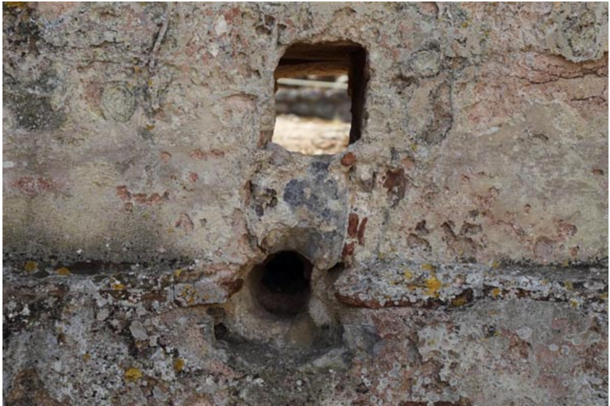
Fig. 5 - Detalle de los orificios de los muros para la canalización del agua (foto de Unicity S.p.A.).
