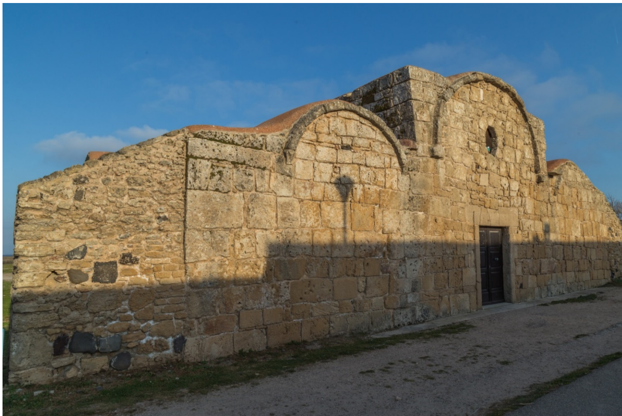
Fig. 6 - Fachada de la iglesia de San Juan (foto de Unicity S.p.A.)
