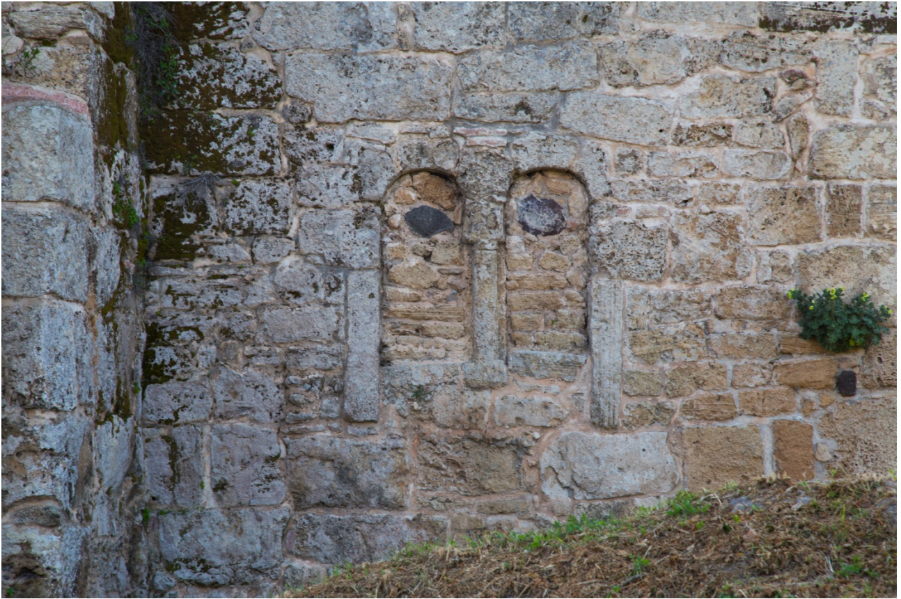
Fig. 8 - Detalle de un ajimez obstruido (foto de Unicity S.p.A.)
