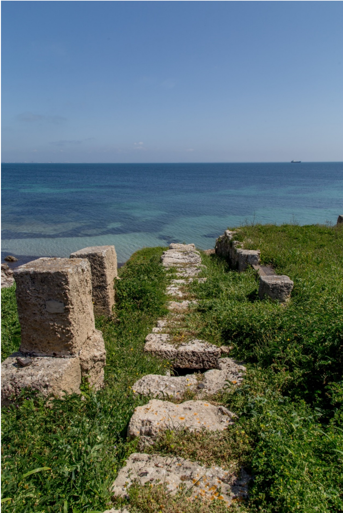
Fig. 10 - Alcantarilla dirigida hacia el desagüe del mar (foto de Unicity S.p.A.)
