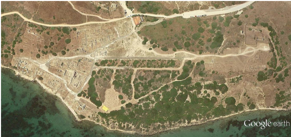
Fig. 1 - Tharros: se observan claramente las dos grandes calles que llevan desde el centro hasta la cima de la colina de Su Muru Mannu (a la derecha), y la división en barrios está creada por las mayores vías urbanas (de Google Earth)
