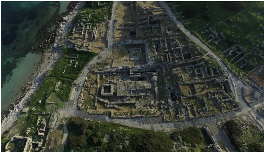
Fig. 2 - Las vías que definen el barrio central de Tharros (foto de Unicity S.p.A.)
