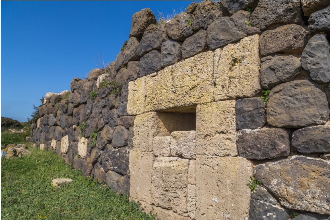
Fig. 2 - Muro delimitante de las fortificaciones, cuya poterna fue obstruida en la época posterior (foto de Unicity S.p.A.)
