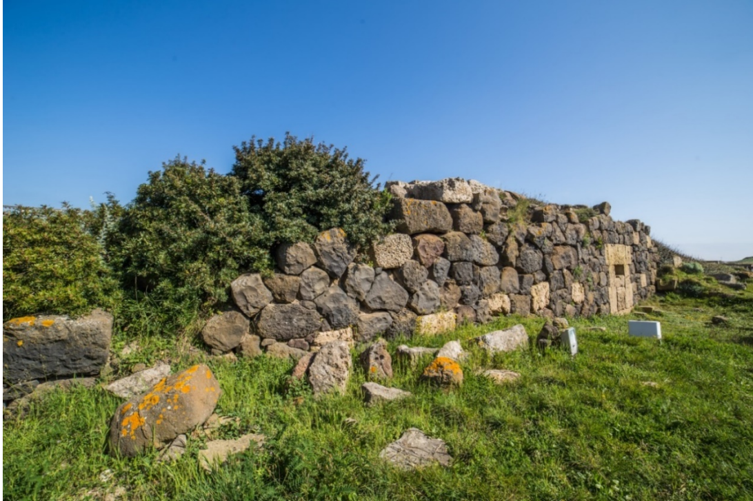
Fig. 4 - El muro delimitante en basalto con bloques regulares de arenisca (foto de Unicity S.p.A.)
