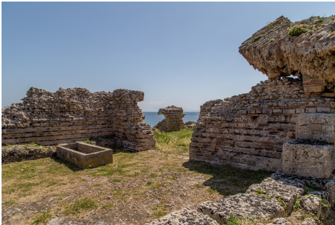
Fig. 33 - El vestuario de las termas del convento viejo con la entrada al frigidarium y, a la izquierda, la tumba bizantina englobada en una estructura moderna de hormigón (foto de Unicity S.p.A.)
