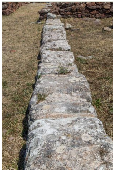
Fig. 7 - Muro portante en opus quadratum (foto de Unicity S.p.A.).
