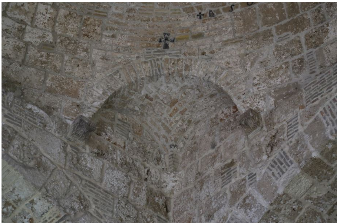
Abb. 2 - Detail des Halbkreuzgewölbes, das die Verbindung zwischen der runden Kuppel und dem quadratischen Feld bildet (Foto von Unicity S.p.A.).
