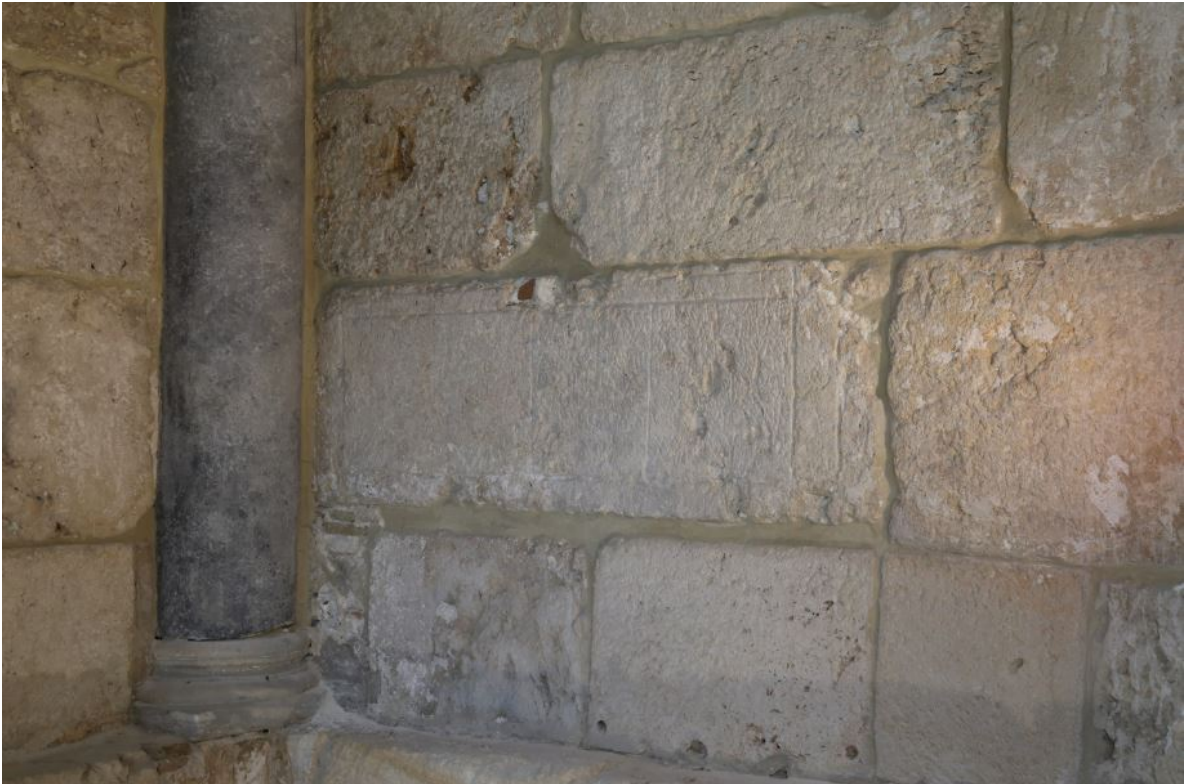
Abb. 2 - Element mit Inschriften, wiederverwendet im linken Schiff des östlichen Arms (Foto von Unicity S.p.A.).
