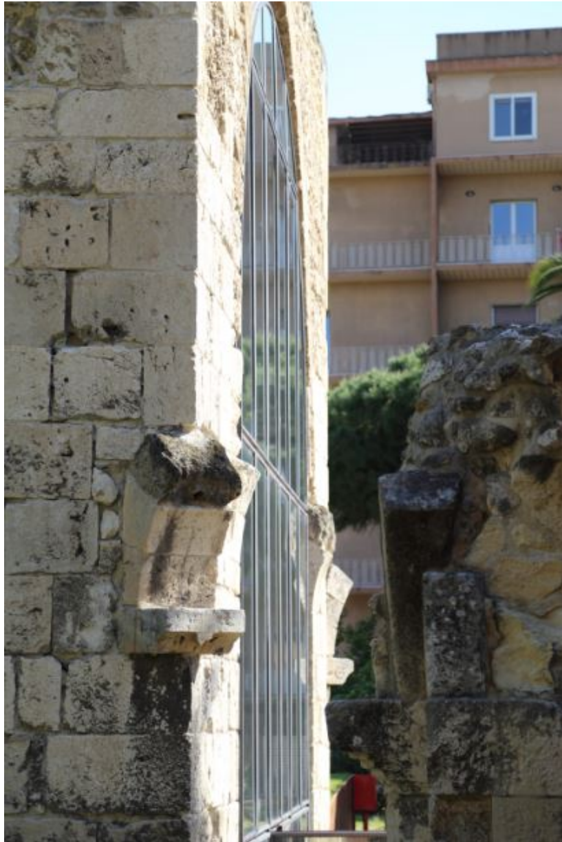
Abb. 3 - Simse an der Nordwestseite des Kuppelkörpers (Foto von Unicity S.p.A.)
