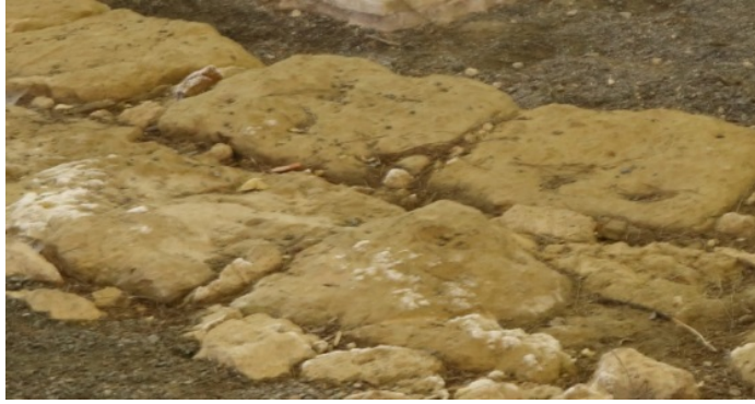
Abb. 3 - „Kleine Basilika“: Detail der Bautechnik (Foto von Unicity S.p.A.).
