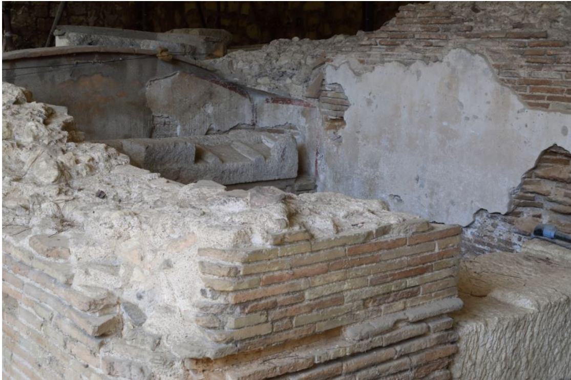
Abb. 2 - Mausoleum: Detail der Mauertechnik aus Ziegeln (Foto von Unicity S.p.A.).
