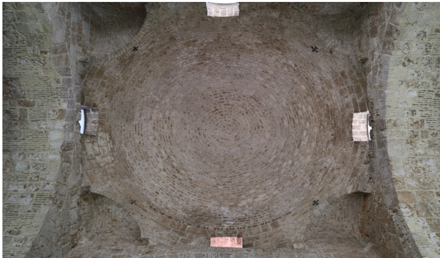
Abb. 8 - Die Kuppel mit den Anschlussfeldern, gesehen von unten (Foto von Unicity S.p.A.).
