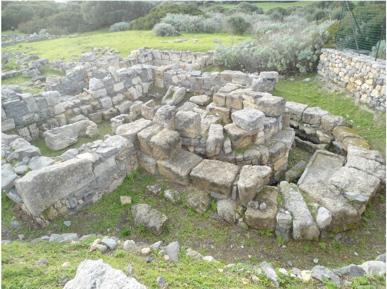
Abb. 4 - Friedhofsbasilika, Apsisbereich, Ansicht des Bereichs von Norden (Foto von C. Cocco).
