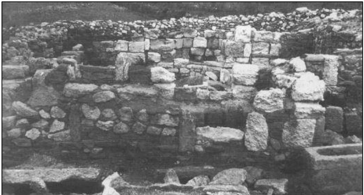
Abb. 4 - Mauer aus opus africanum im Verbindungskorridor zwischen Raum A und Friedhofsbasilika (aus: FANTAUZZI, DE VINCENZO 2013, S. 9, Abb. 2).
