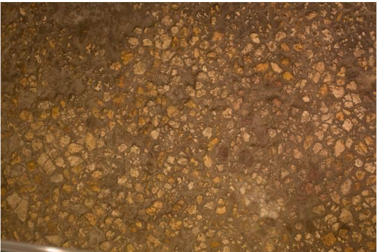
Abb. 1 - Bodenbelag des Portikus (Foto von Unicity S.p.A.).
