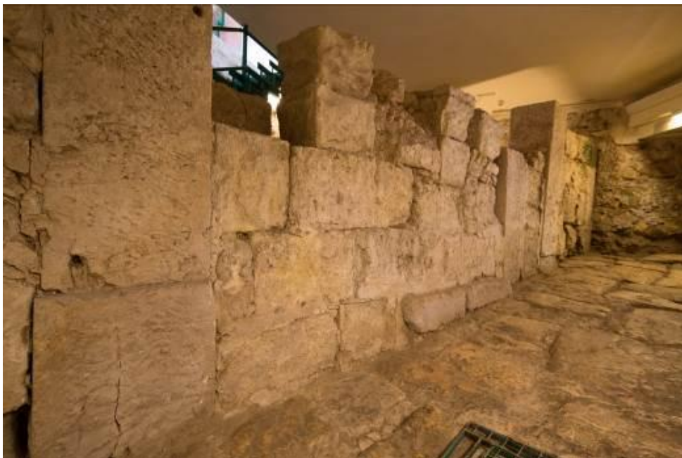
Abb. 1 - Mauer aus opus africanum (Foto von Unicity S.p.A.).
