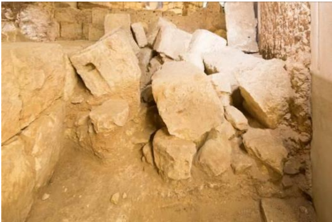
Abb. 4 - Blöcke des zweiten Einsturzes auf der linken Seite der Querwand, auf einer Schicht des vorausgehenden Einsturzes liegend (Foto von Unicity S.p.A.).
