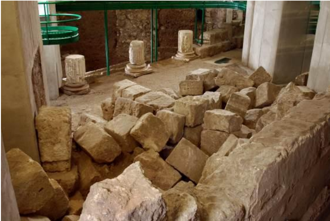
Abb. 2 - Zweiter Einsturz der Seitenwände des Portikusses (Foto von AFS).
