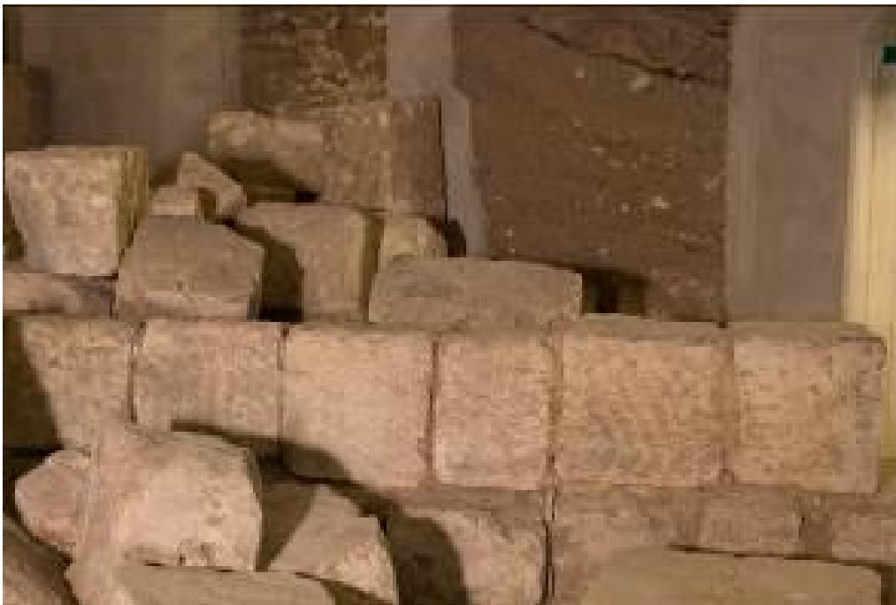
Abb. 1 - Quermauer, bestehend aus wiederverwendeten Blöcken des ersten Einsturzes und aufgerichtet auf einer eingestürzten Schicht des Portikusses (Foto von R. Martorelli).
