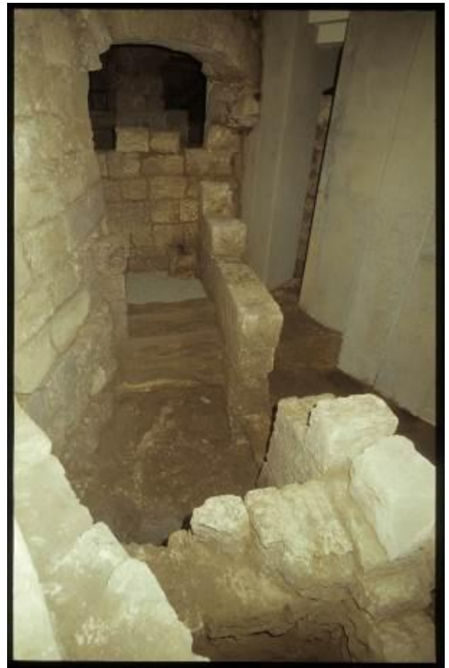
Abb. 3 - Wohnhaus im Nordosten: Erste Treppe und Treppenabsatz mit Latrine (Foto von AFS).
