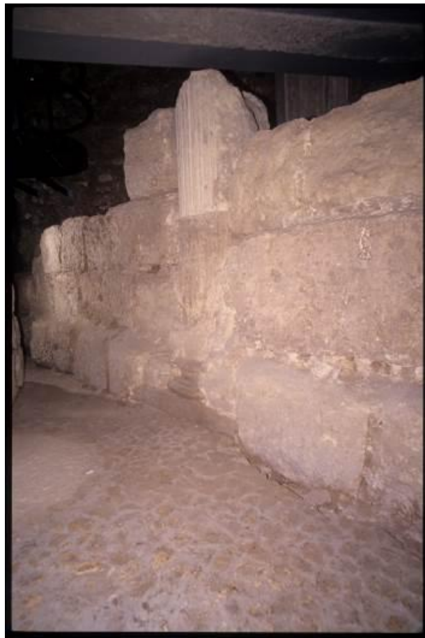
Abb. 3 - Mit geformten Blöcke eingemauerte Säule (Foto von AFS).
