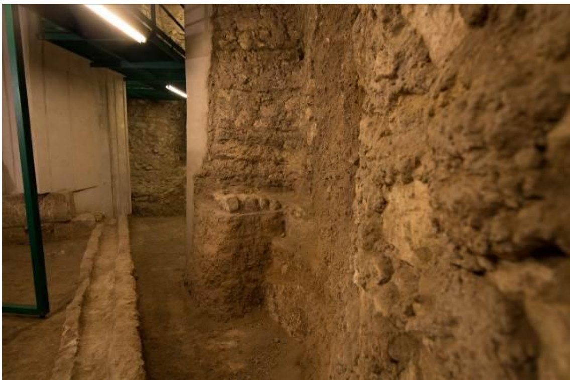
Abb. 3 - Kleiner Kanal im Unterbau der Kirche (Foto von Unicity S.p.A.).
