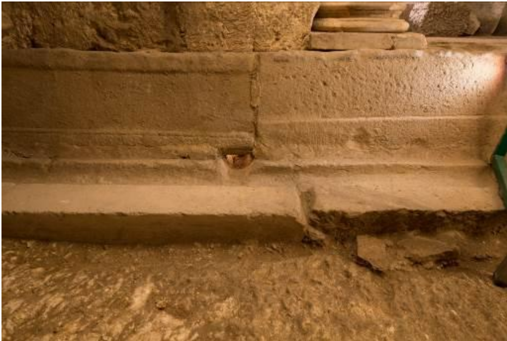
Abb. 4 - Kleiner Kanal in Querrichtung, der Wasser zur Zisterne leitet (Foto von Unicity S.p.A.).
