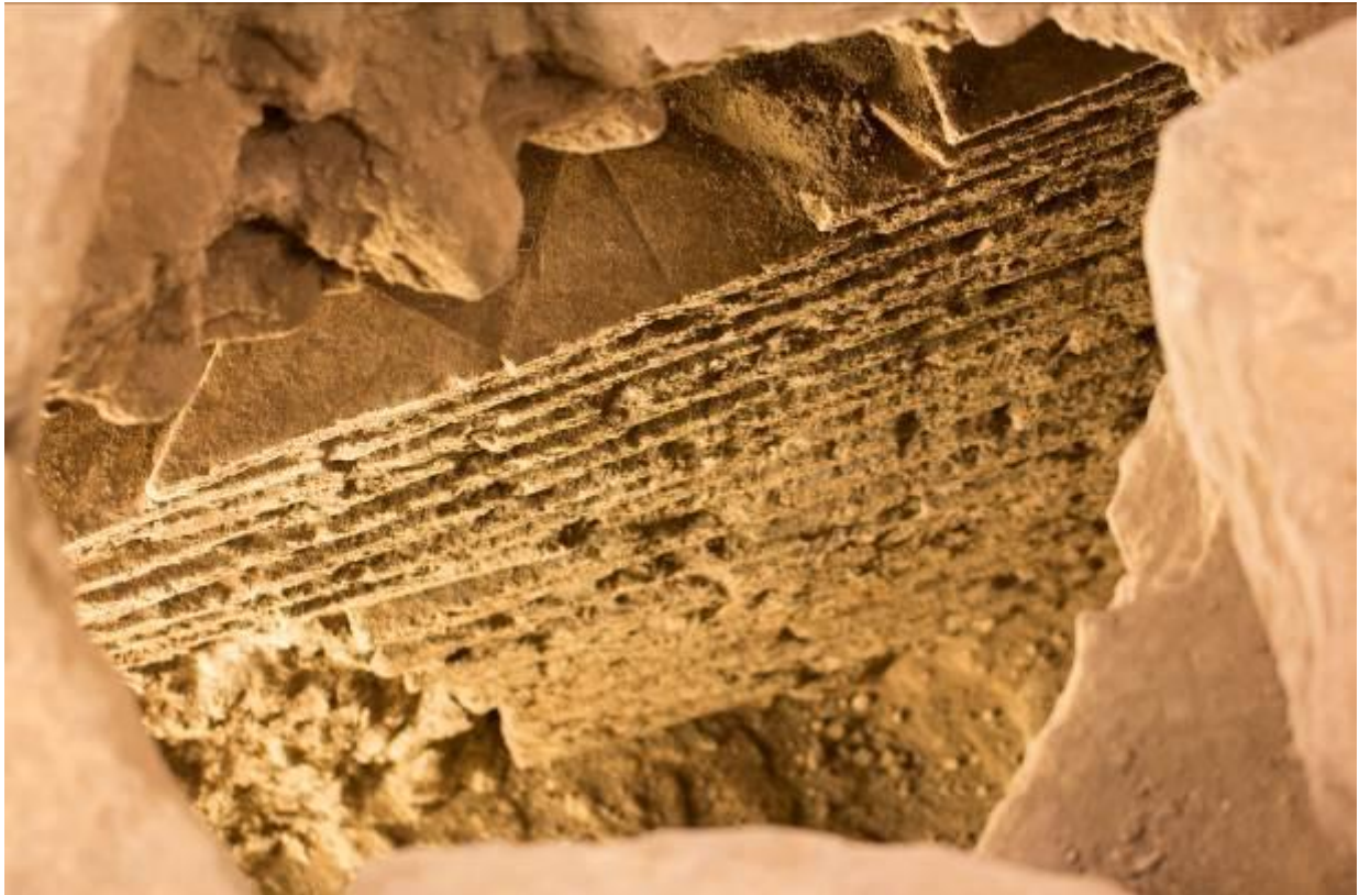
Abb. 2 - Auskleidung der Kanalisationsleitung (Foto von Unicity S.p.A.).
