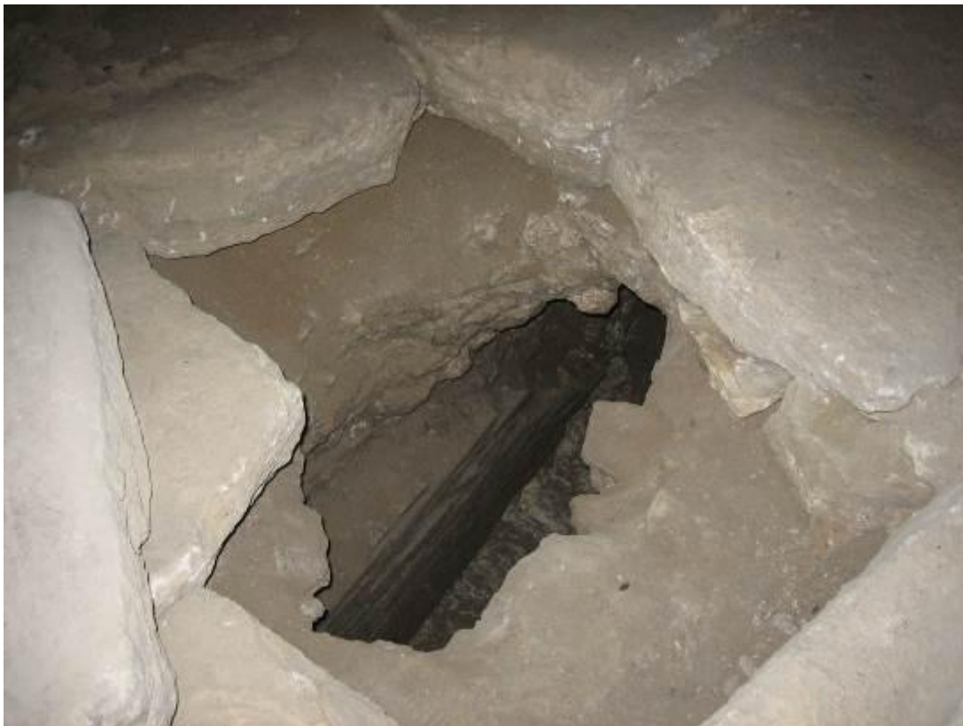
Abb. 1 - Kanalisationsleitung während der Grabungsarbeiten (Foto von Unicity S.p.A.).
