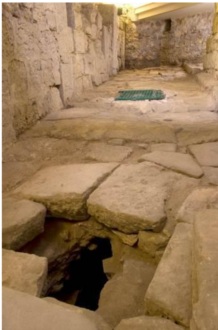
Abb. 1 - Inspektionsschacht der Kanalisation, offen auf der gepflasterten Straße (Foto von Unicity S.p.A.).
