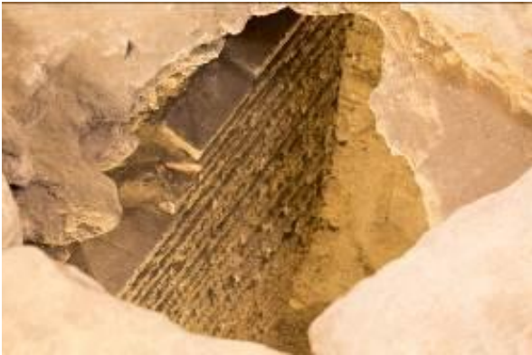
Abb. 2 - Innenwand des Kanalisationskanals (Foto von Unicity S.p.A.).
