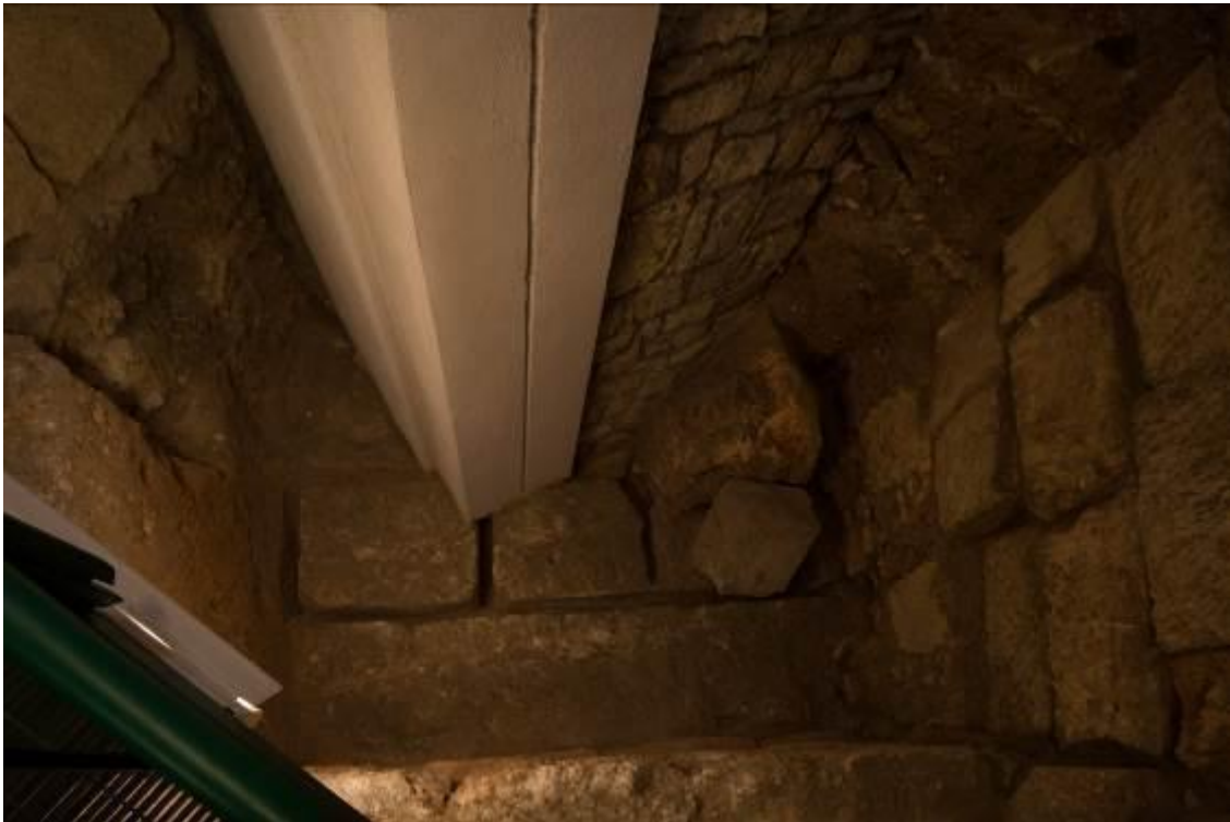
Abb. 1 - Rechtwinklige Schnitte zum Abbauen der Blöcke (Foto von Unicity S.p.A.).
