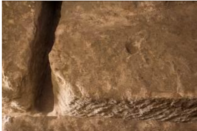
Abb. 3 - Detail des Einschnitts zwischen zwei Kalksteinblöcken (Foto von Unicity S.p.A.).
