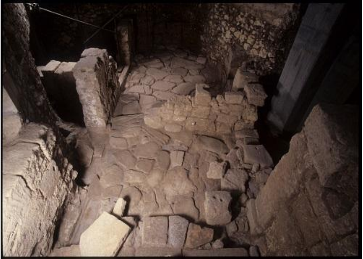
Abb. 2 - Gepflasterte Straße und einige Abschnitte der Scheidemauer, die unterschiedliche Bauphasen belegen (Foto von AFS).
