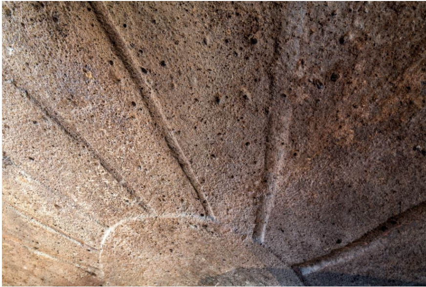
Abb. 8 - Die Decke des Endonarthex (Foto von Unicity S.p.A.).
