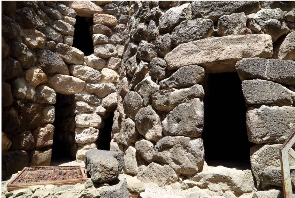
Abb. 2 - Rechts der Eingang zum Bergfried (Foto von Unicity S.p.A.).
