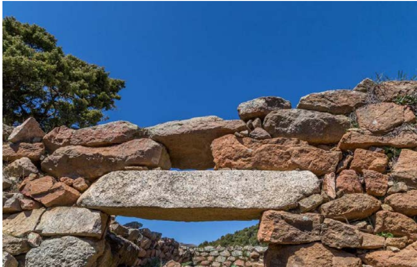
Abb. 2 - Eingang mit Architrav des Raums C des Megaron -Tempels 1 (Foto von Unicity S.p.A)
