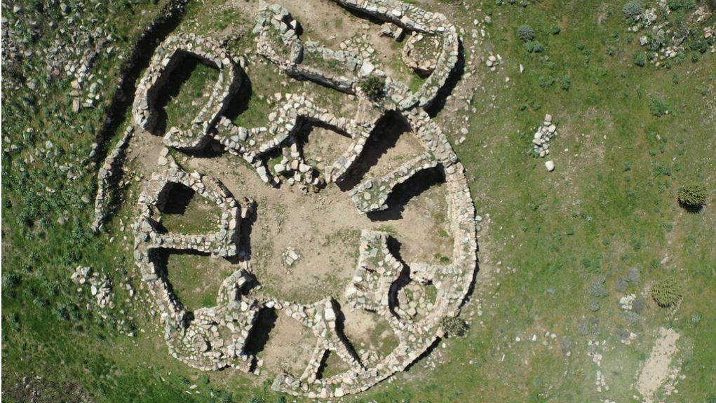
Abb. 2 - Luftbild der Insula 1 von S'Arcu 'e Is Forros-Villagrande Strisaili (Foto von Unicity S.p.A.).
