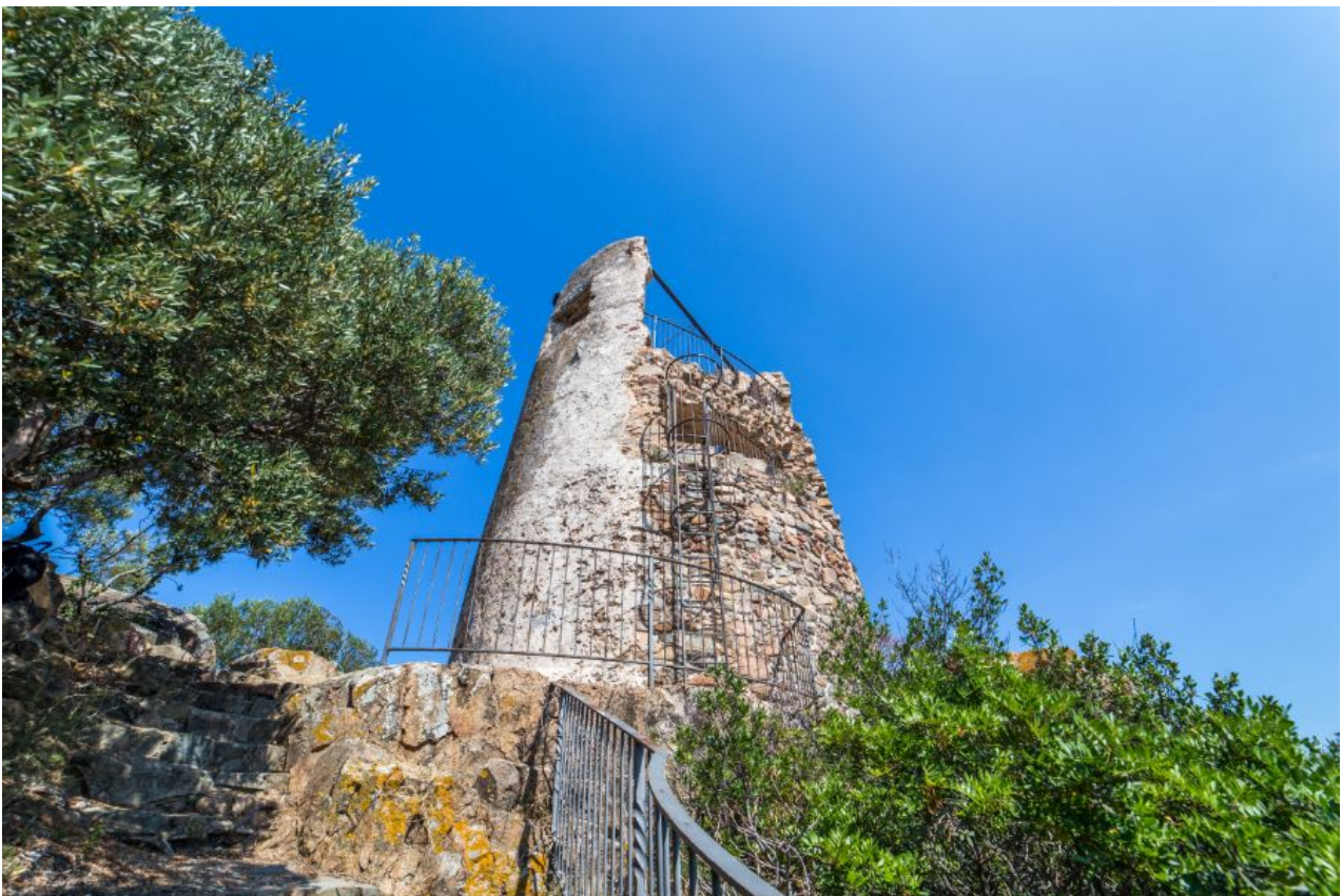
Abb. 5 - Der Turm von S. Gemiliano, gesehen von Osten (Foto von Unicity S.p.A.).
