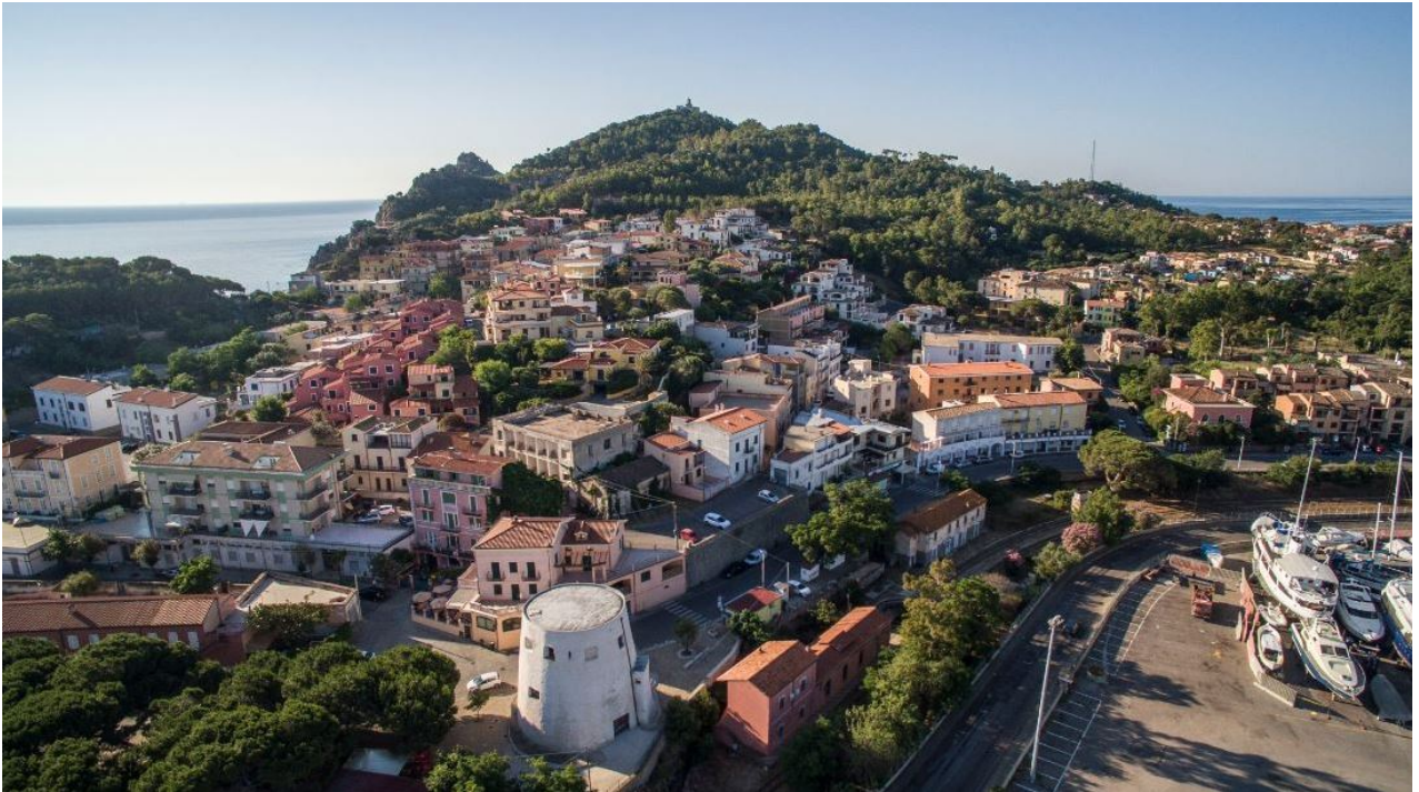
Abb. 2 - Im Vordergrund der Turm von San Miguel, im Hintergrund, auf dem Gipfel des Landausläufers, der Bellavista-Leuchtturm (Foto von Unicity S.p.A.).
