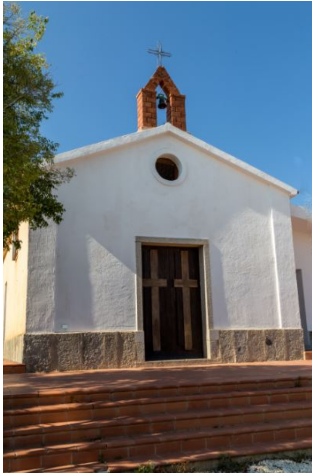
Abb. 3 - Die Fassade der San Gemiliano (Foto Unicity S.p.A.).
