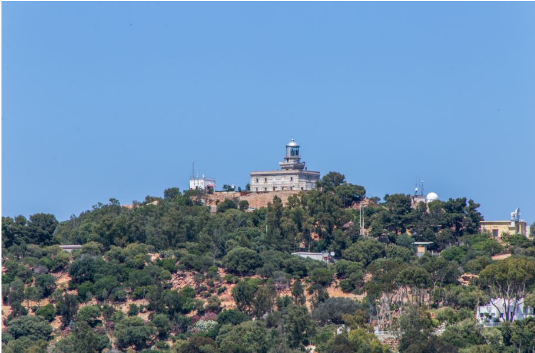
Abb. 10 - Der Leuchtturm von Capo Bellavista (Foto von Unicity S.p.A.).
