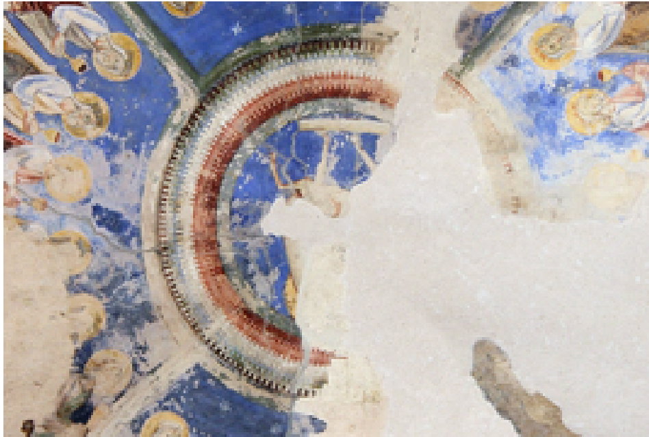
Abb. 2 - Östliches Gewölbe: Das zentrale Kopfschild (Foto von Unicity S.p.A.).
