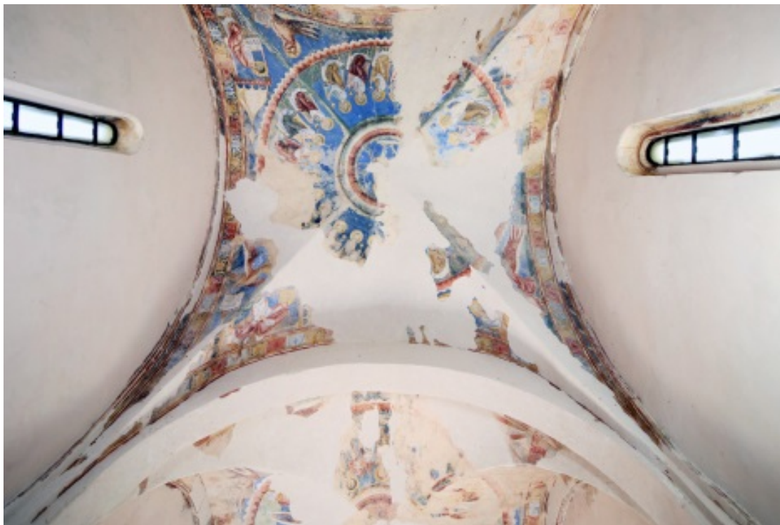
Abb. 1 - Östliches Gewölbe: Die Verehrung des Lamm Gottes (Foto von Unicity S.p.A.).
