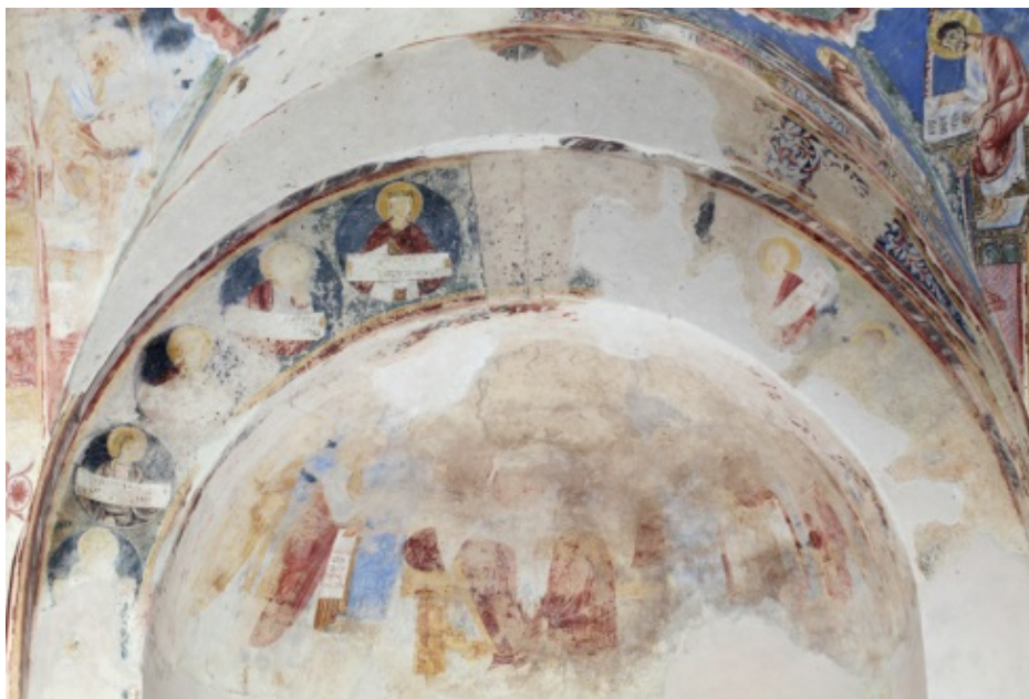
Abb. 1 - Die Fresken des Apsisbogens (Foto von Unicity S.p.A.).
