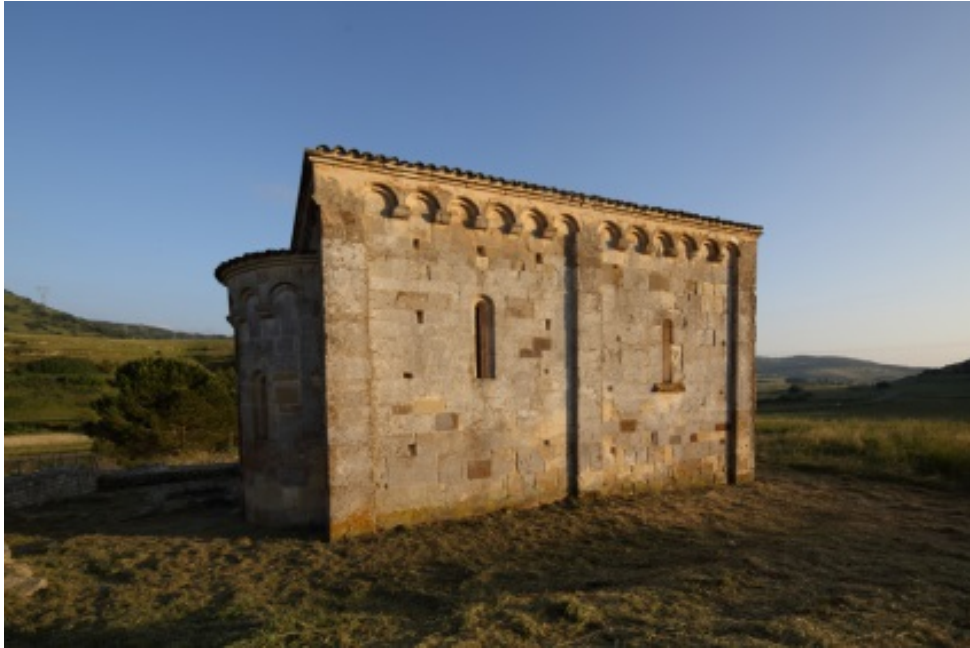
Abb. 1 - Lato settentrionale (foto di Unicity S.p.A.).
