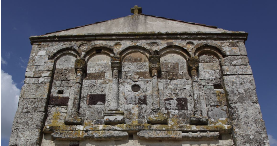
Abb. 2 - Der obere Teil der Fassade (Foto von Unicity S.p.A.).
