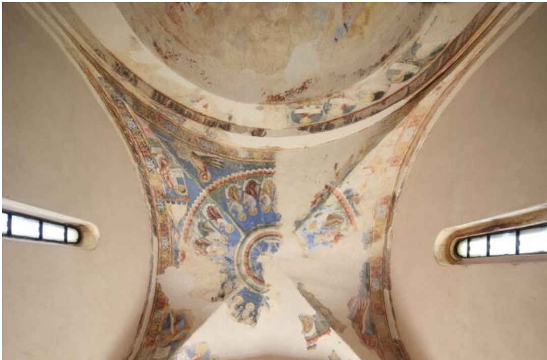
Abb. 3 - Das Kreuzgewölbe eines der Joche (Foto von Unicity S.p.A.).
