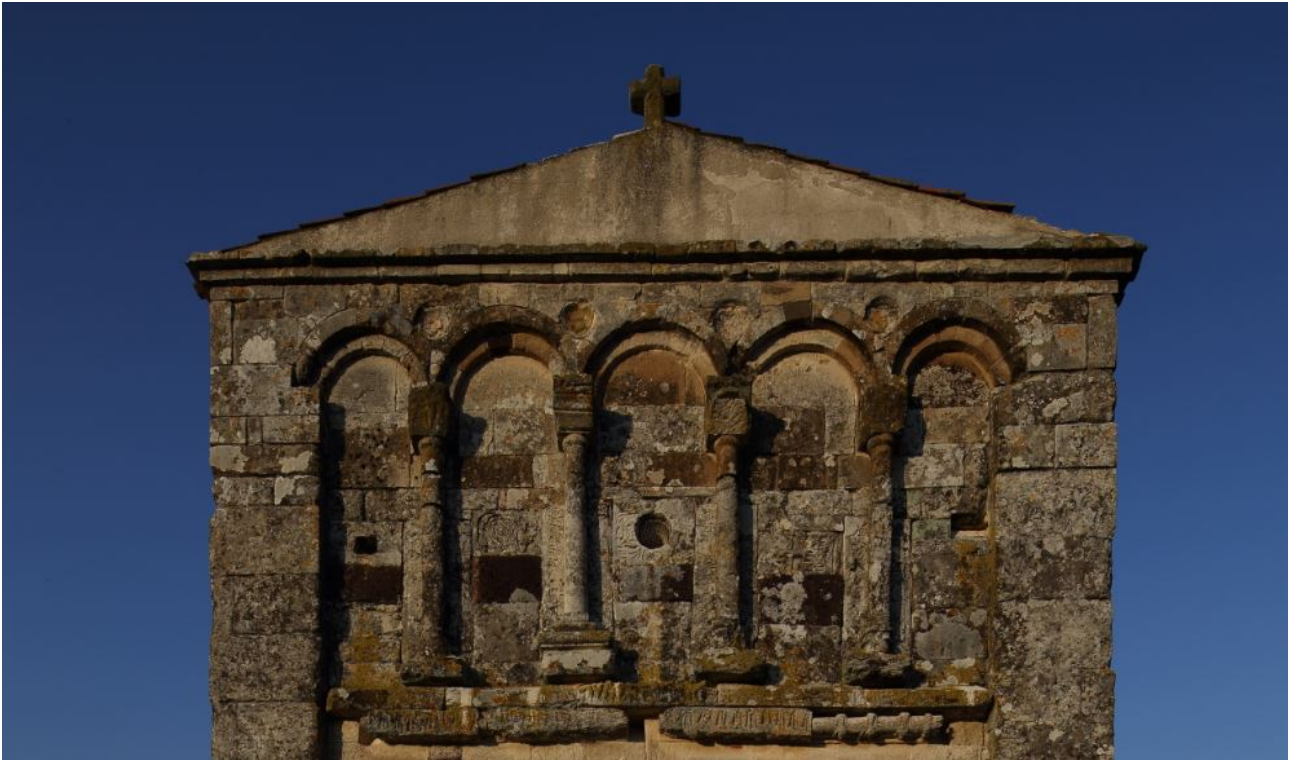
Abb. 5 - Detail der Fassade mit den Keramikbecken (Foto von Unicity S.p.A.).
