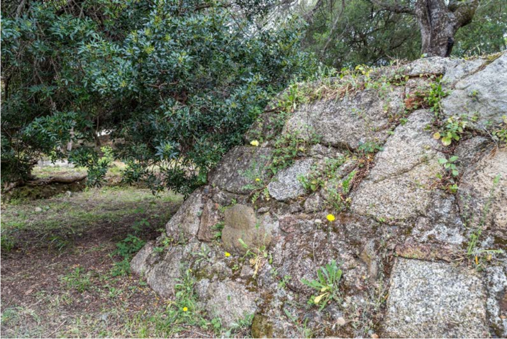
Abb. 5 - Luogosanto, Palazzo di Baldu: Konisches Fundament an der Basis des Turms (Foto von Unicity S.p.A.).
