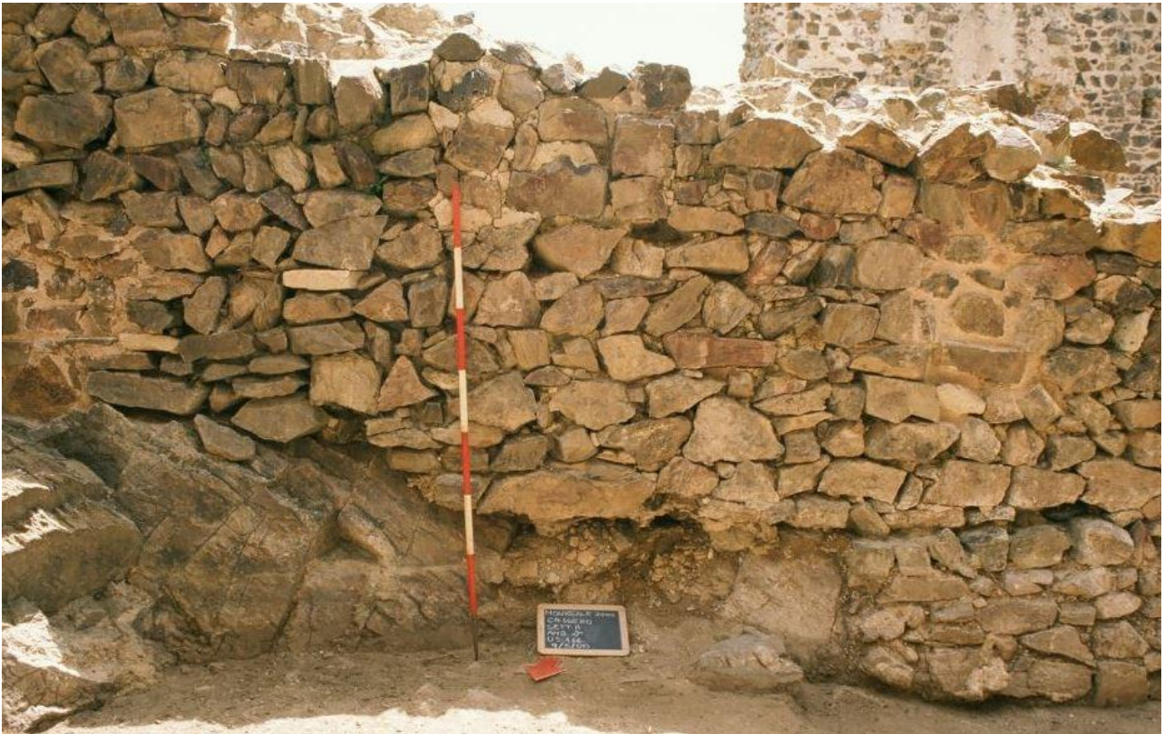
Abb. 2 - Mauerwerk im Inneren des Raums theta (Foto von R. Bordicchia).
