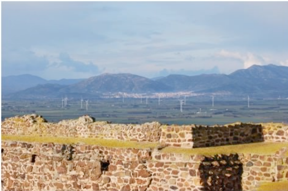
Abb. 12 - Der obere Teil der Außenmauer des Bergfrieds mit den Wachgänge (Foto von R. Bordicchia).
