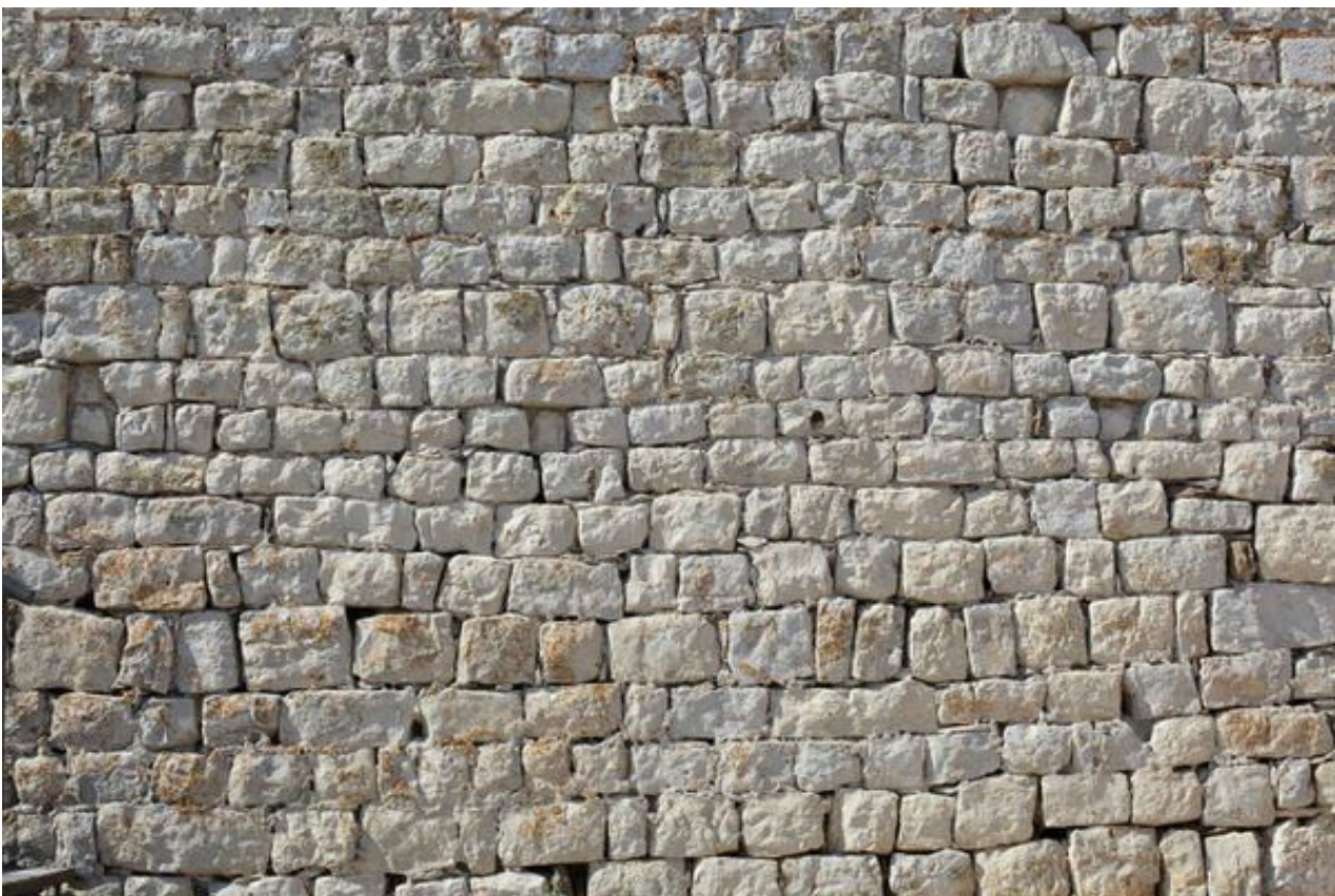
Abb. 2 - Detail der Mauerstruktur des Turms, mit reihe aus behauenen Blöcken aus lokalem Stein (Foto von Unicity S.p.A.).
