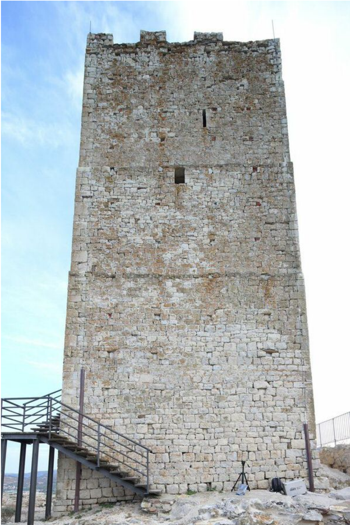
Abb. 4 - Die Nordseite des Turms: Auf der Außenseite sind die Stufen sichtbar, die die drei Stockwerke des Turms markieren (Foto von Unicity S.p.A.).
