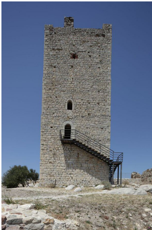
Abb. 1 - Haupteingang zum Turm, Ostseite (Foto von Unicity S.p.A.).
