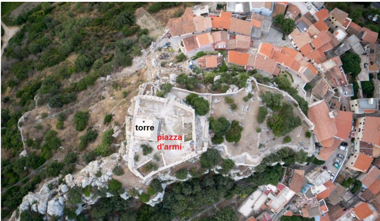
Abb. 1 - Die Fava-Burg mit Angabe des Waffenplatzes und des Turms (Überarbeitung von M. G. Arru, Foto von Unicity S.p.A.).
