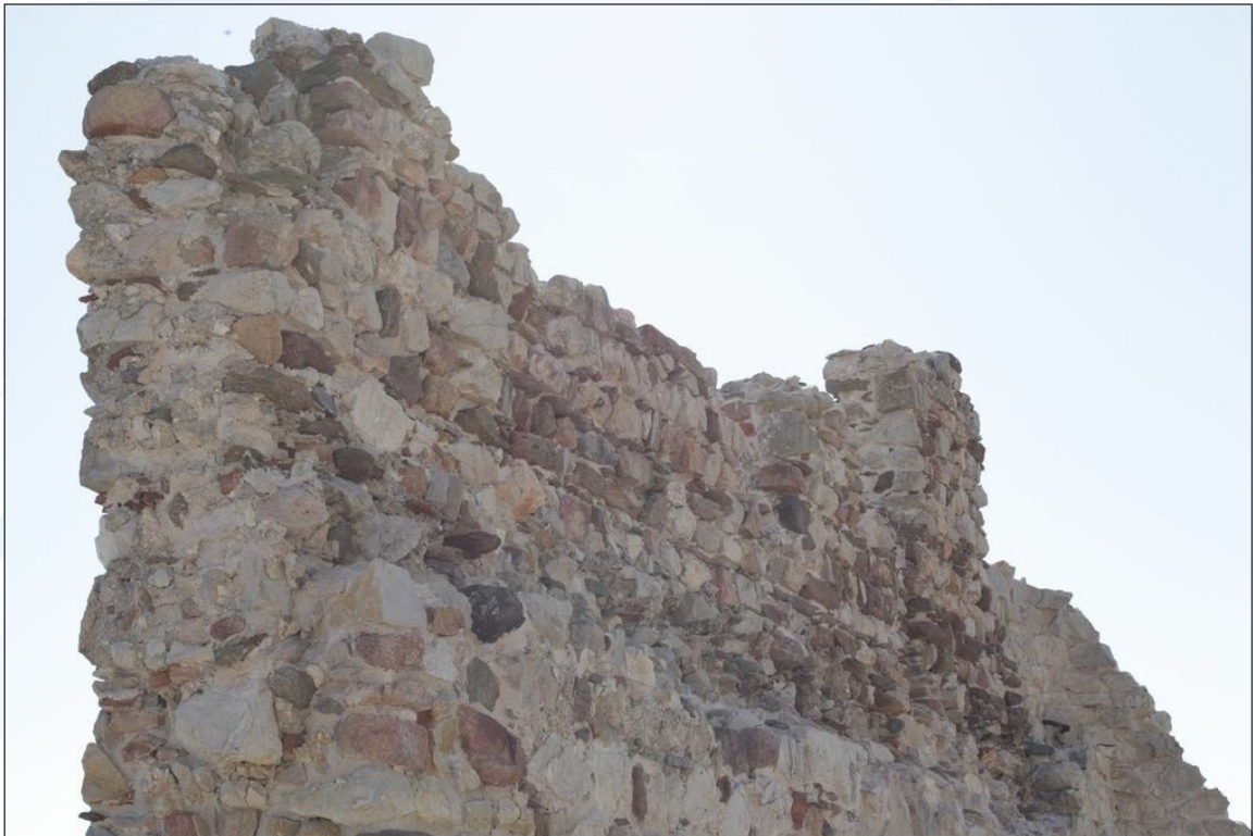
Abb. 2 - Detail des Wachgangs der inneren Ringmauer (Foto von Unicity S.p.A.).
