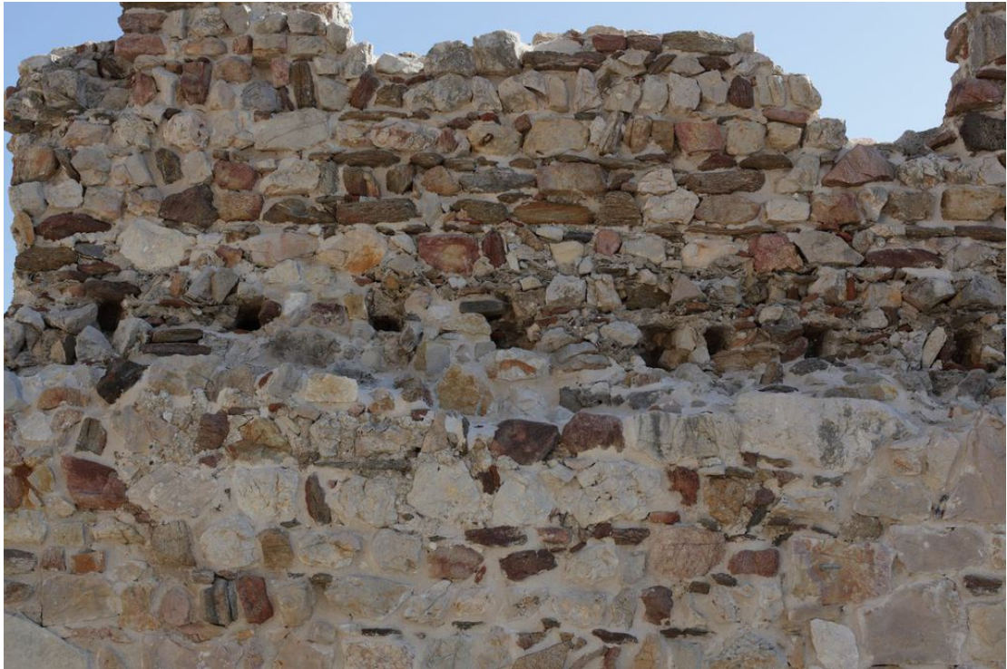
Abb. 4 - Öffnungen für die Aufnahme der horizontalen Stützbalken des Wachgangs (Foto von Unicity S.p.A.).
