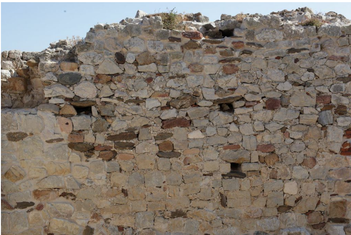
Abb. 3 - Öffnungen für die Aufnahme der vertikalen Holzbalken (Foto von Unicity S.p.A.).
