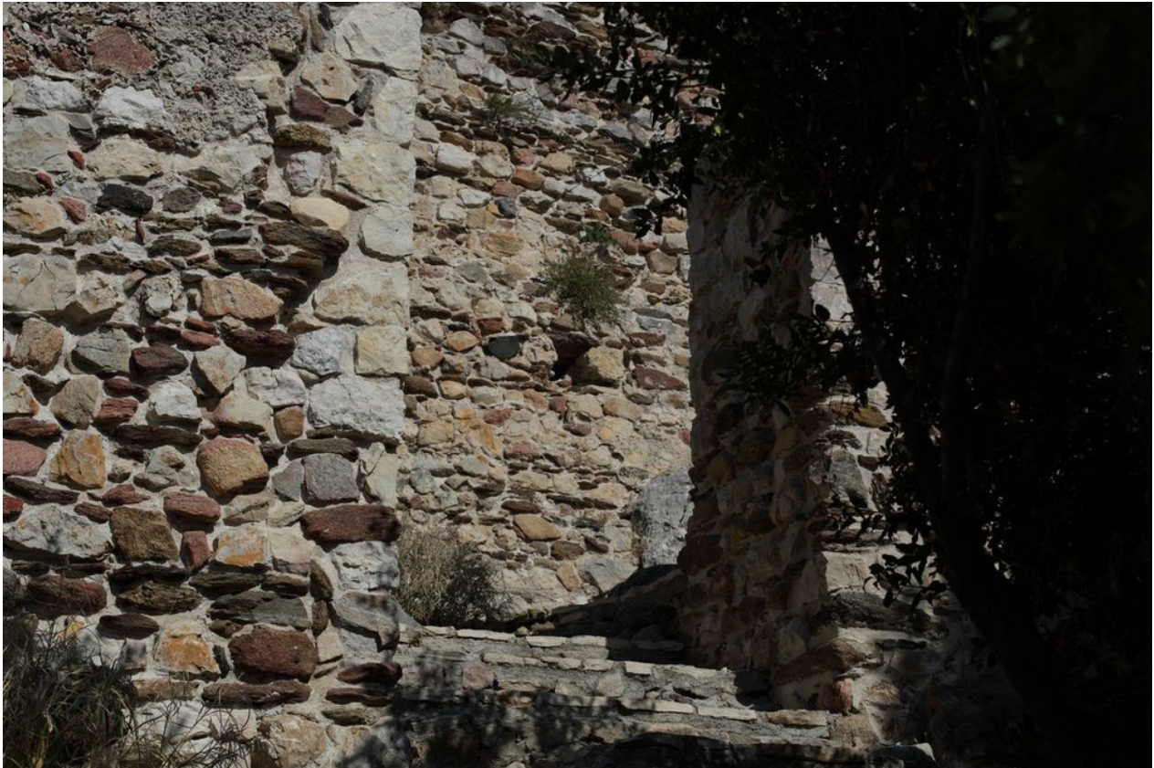
Abb. 4 - Zugang zur zweiten Ringmauer (Foto von Unicity S.p.A.).
