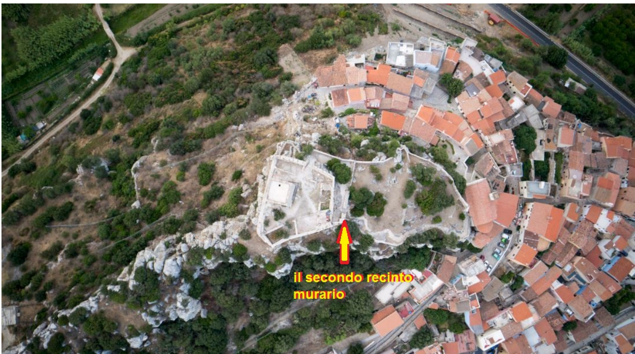
Abb. 1 - Die Fava-Burg mit Angabe der Ringmauern (Überarbeitung von M. G. Arru, Foto von Unicity S.p.A.).
