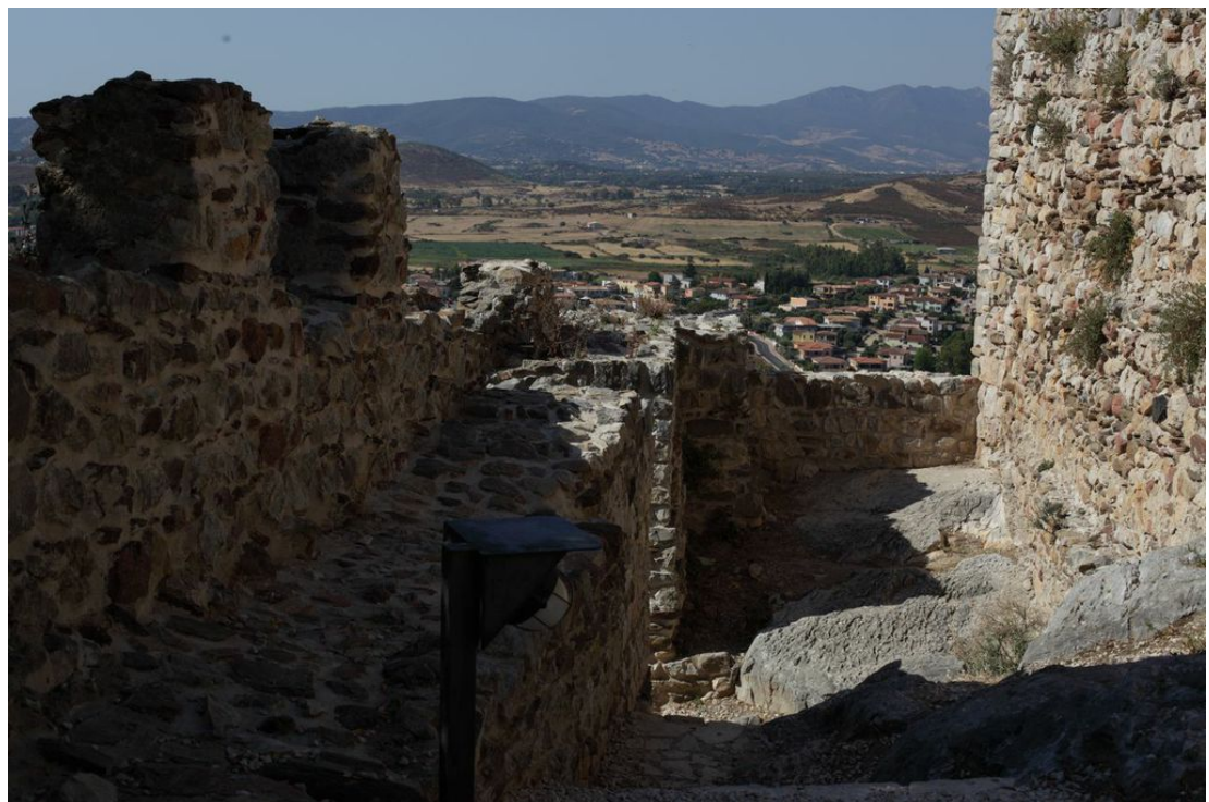
Abb. 3 - Die Ringmauer wurde direkt auf dem Fels errichtet, dem Gefälle folgend (Foto von Unicity S.p.A.).
